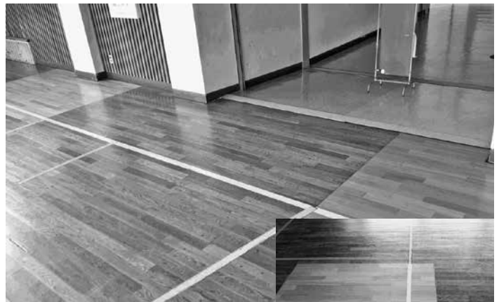
部分補修した床（出雲崎小）
