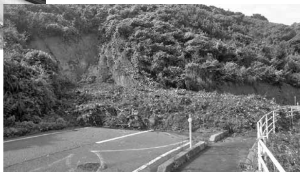
豪雨災害現場（町道乙茂久田線）
