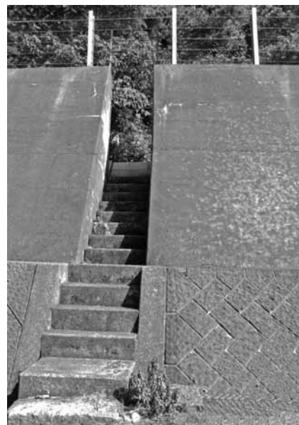
津波避難路整備区域予定地 (井鼻1区・木折町2区)
