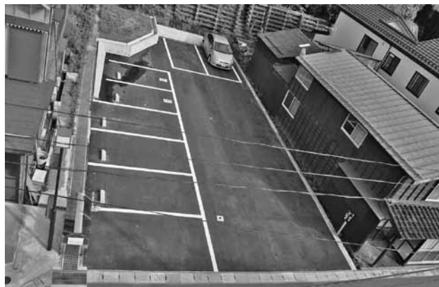
妻入り会館駐車場
