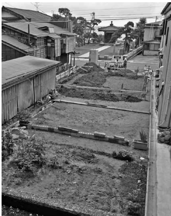
工事が始まった若者向け町営住宅（石井町）
