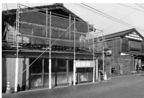
改装中の町家展示施設（旧津又邸）
