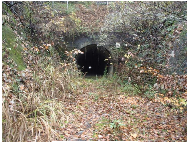
中永トンネル
